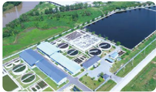
Hệ thống xử lý nước thải khu dệt may
